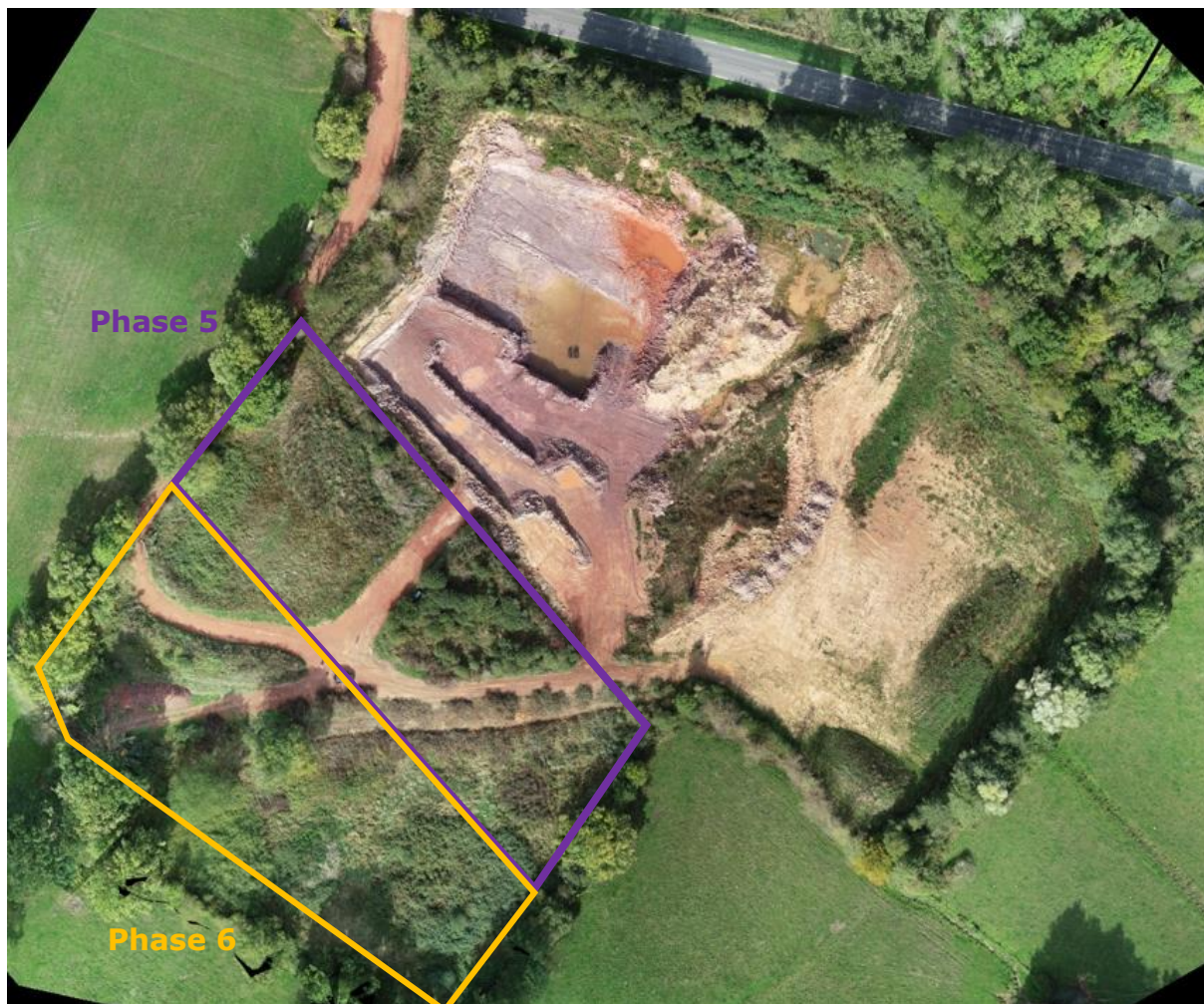
Photographie 1 : Etat actuel de la carrière et phases restantes (Source : Photo drone EDILIAN)
